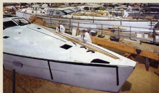
Il cantiere inglese di Southampton dove sono in costruzione cinque Oyster 62
